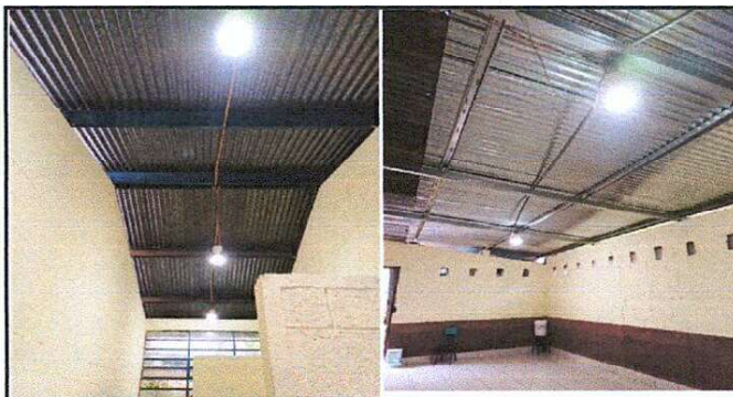
Foto 4: Accesorio de electricidad e iluminación finalizado.
